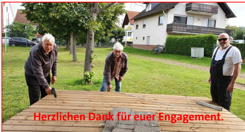
Arbeitseinsatz auf dem Bolzplatz in Niedernhausen: Michael Kierstein, Dieter Gross, Dieter Klingert und Wolfgang Allmann haben die Ärmel hochgekrempt und die verwitterten Holzbretter der Sitzfläche durch neue ersetzt. Unterstützt wurden sie vom Bauhof durch Hans-Georg Ulbricht.
